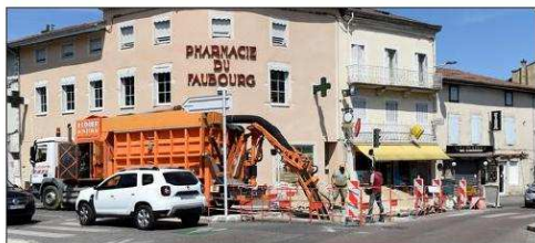
Les travaux ont débuté le lundi 15 juillet. Photo Progrès/Catherine AULLAZ
